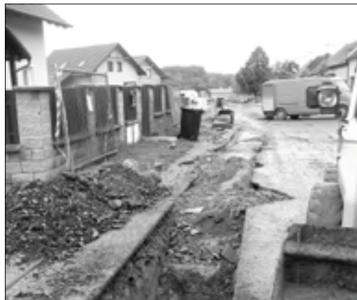
Rekonstrukce kanalizace v Moravní ulici si vyžadovala trpělivost zde bydlících obyvatel a dnes již slouží ke spokojenosti všech.
