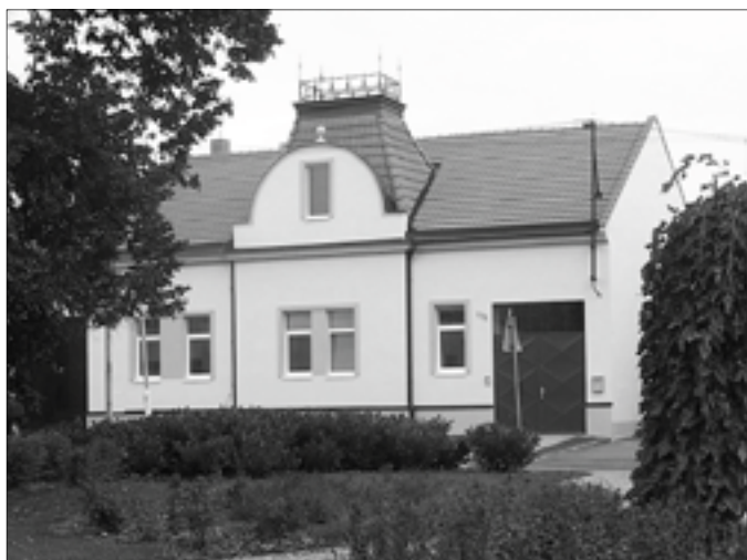
Budova fary se v letošním roce dočkala opravy fasády. Obec Huštěnovice přispěla 90 000 Kč.
