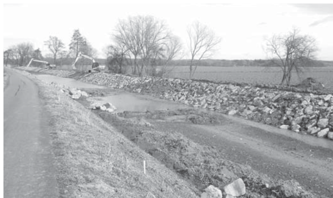
Dno Baťova kanálu je čištěno a břehy zpevňovány.
