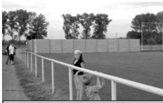
Nově vybudované oplocení sběrného dvora
