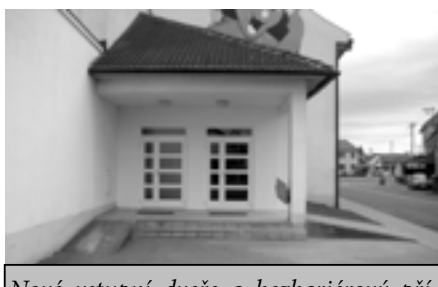
Nové vstupní dveře a bezbariérový přístup do KD
