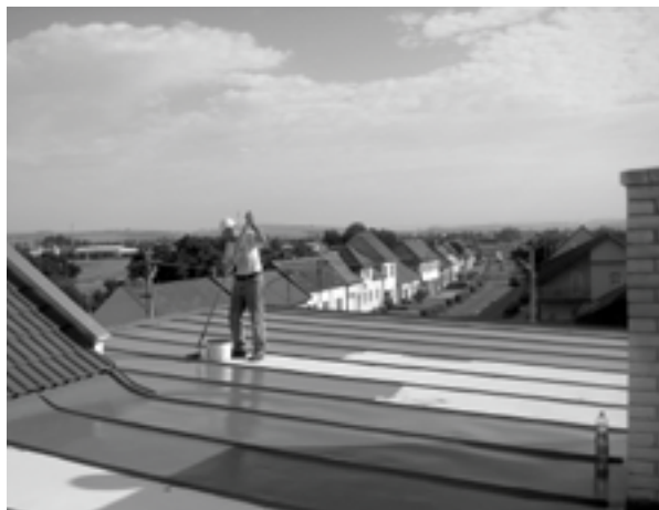
Nátěr střechy KD provádí pracovník OÚ Svatopluk Býček.
