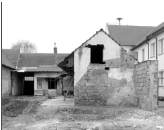
Vyklizený dvůr zdevastovaných budov na čp. 62. Domek je v majetku obce.
