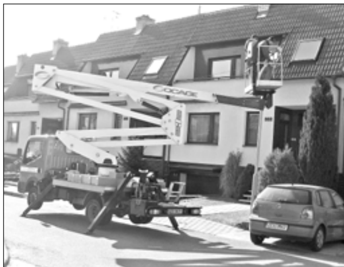
Výměna lamp veřejného osvětlení obce v ulici Klínky.
