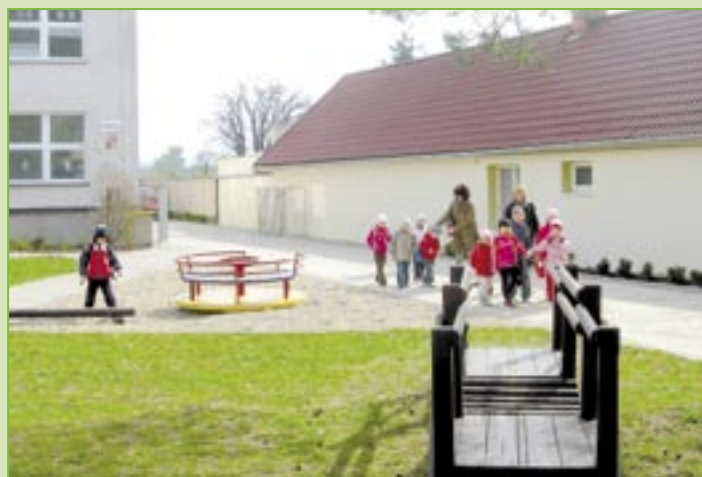
Nový chodník a vjezd před budovou MŠ již slouží dětem.
