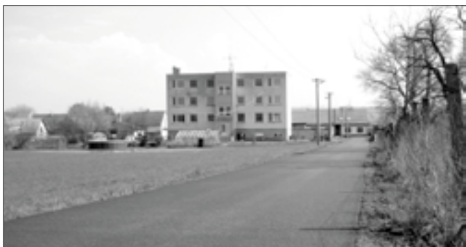
Minulý týden Ředitelství silnic a dálnic dokončilo opravu vozovky kolem bytovek a farmy. Naše obec se na opravě finančně nijak nepodílela, vše bylo v režii ŘSD.
