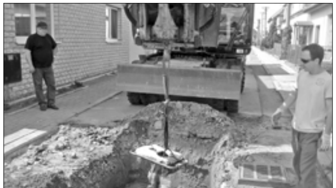
Oprava vpusti a nové napojení do kanalizace v Kvítkové ulici.
