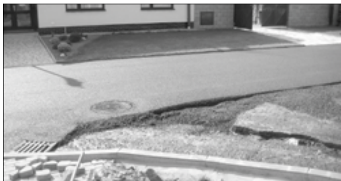
Oprava zátáčky u bytovek.
