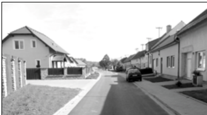
Moravní ulice se dočkala po kanalizaci také nové vozovky
