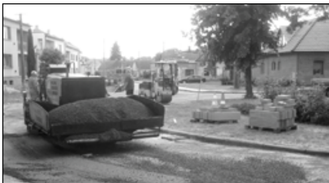
Oprava vozovky v dolní části návsi
