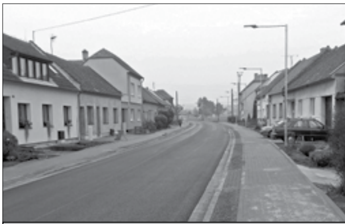
LED osvětlení v Sušické ulici.
