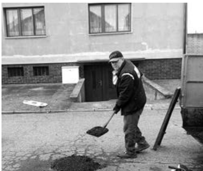
Milan Valenta při opravě vozovky v Nové ulici.
