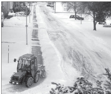
Lednová bohatá sněhová nadílka - odklizení sněhu z chodníků prováděl pracovník obce Milan Valenta, ruční odklizení sněhu na přechodech, zastávkách a před obecními budovami prováděl Miroslav Kryška. Komunikace uklízela firma FYTO Králík.
