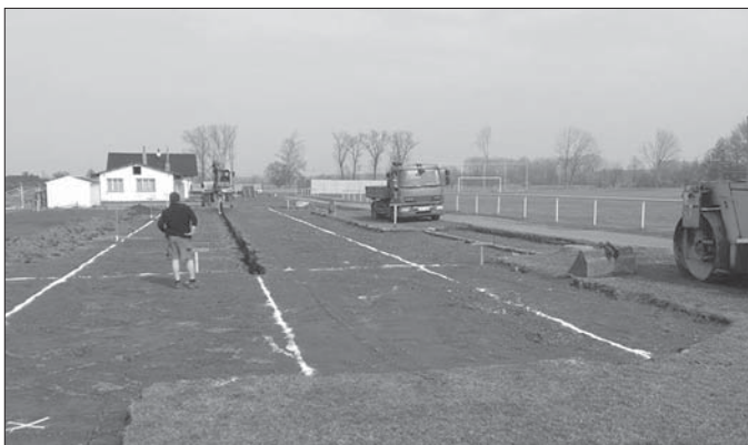
V předposledním březnovém týdnu byly zahájeny práce na stavbě víceúčelového sportoviště V Olší.
