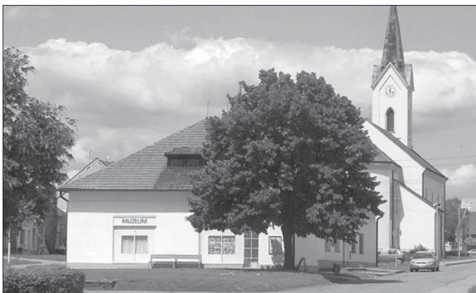
Dokončená oprava fasády domu služeb a muzea.
